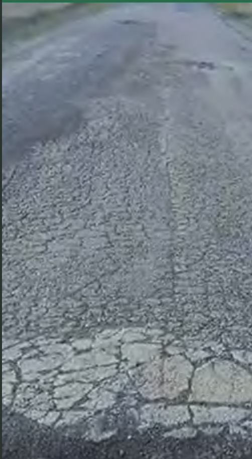
Asfaltvei før arbeid
