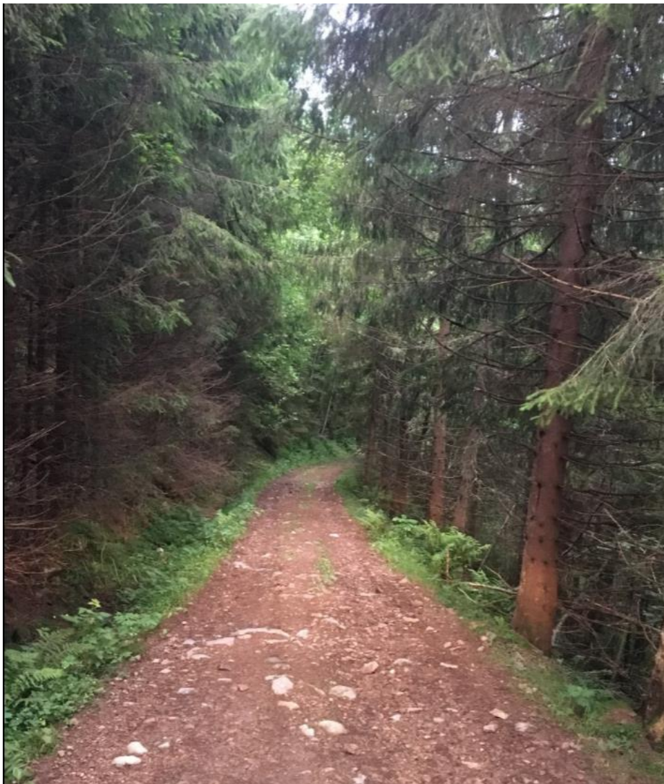
Bilde 1 – Langbratt og meget steinete veg i Bærum, hvor trærne har fått vokse opp i grøfta.
