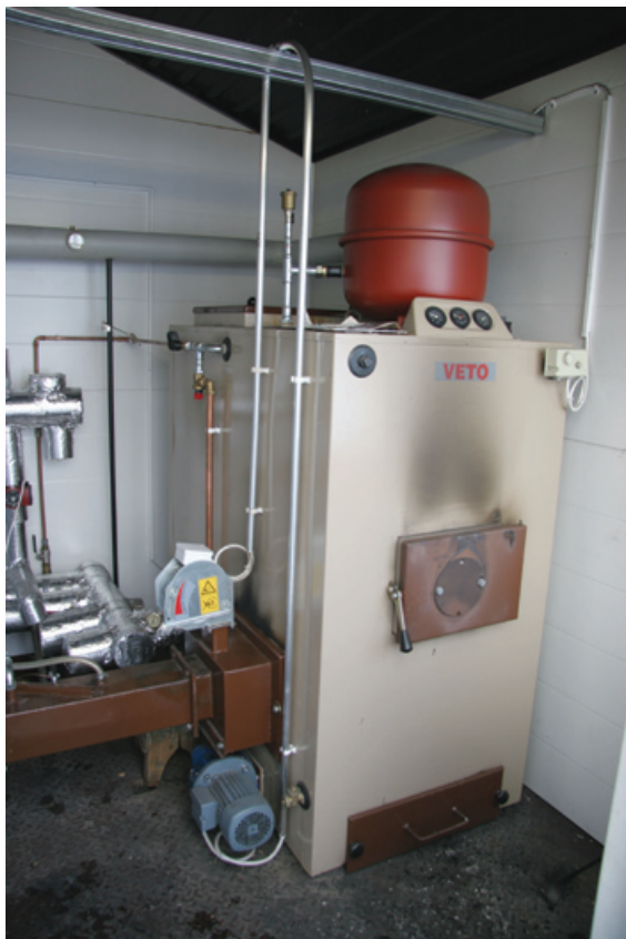
Flisfyringsanlegg, øs
