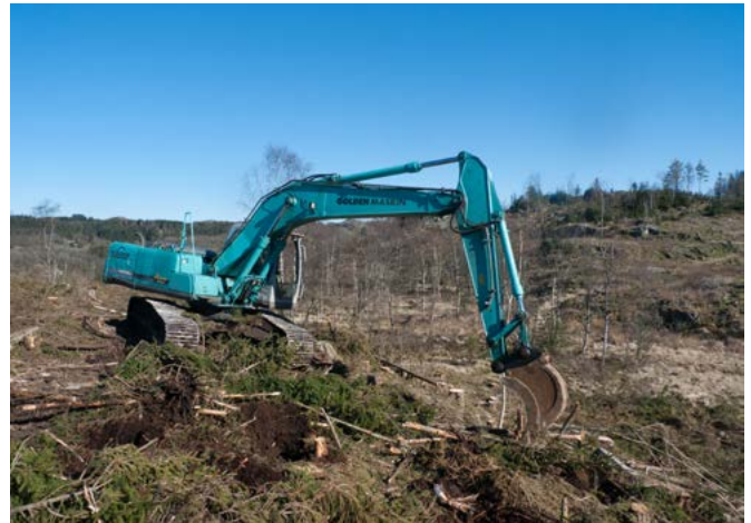
Markberedning med gravemaskin. Foto: Inger S. Fløistad
