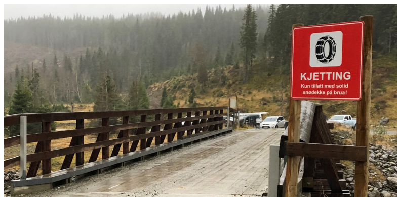
Informasjonsskilt som begrenser bruk av kjetting på trebrua. Foto: Martin Bråthen
