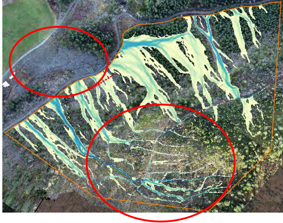
Dreneringsveier ETTER hogst
