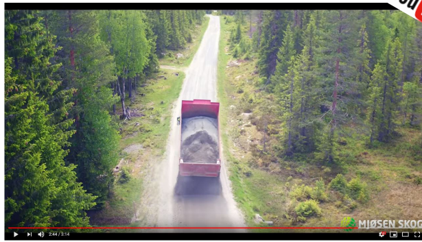
Video 2 - Utlegging av bærelagsforsterkende masser på en velteplass der veien er kjørt i filler. Tips: Utfør dette tiltaket før drifta for å kunne benytte skogfond.
