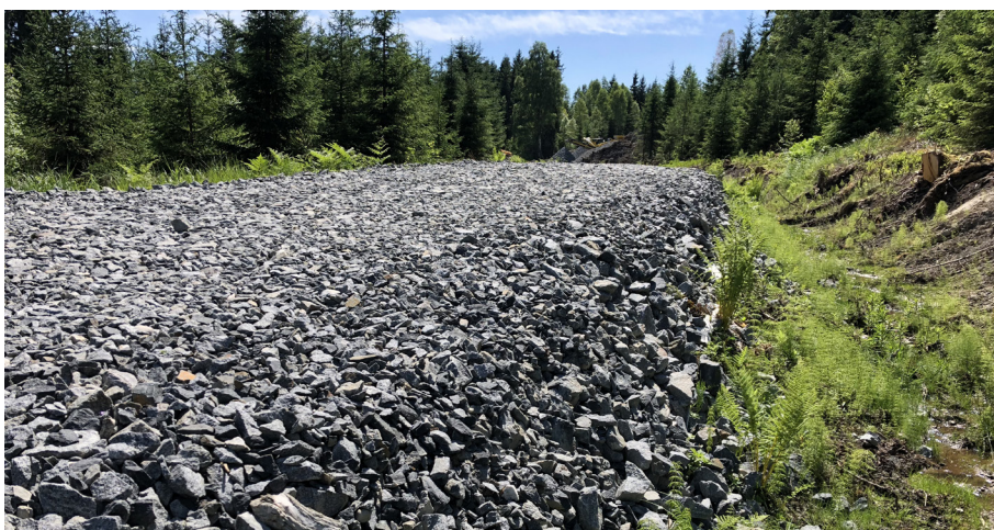
Opprusting av eksisterende vei. Her er knust fjell benyttet til å forsterke bæreevnen. Foto: Martin Bråthen
