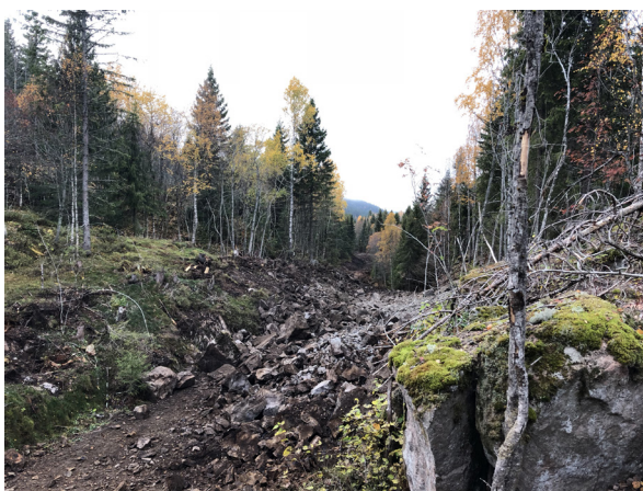
Veitraseen er sprengt ut, nå må massene sorteres og veikroppen bygges opp. Foto: Martin Bråthen, Skogkurs
