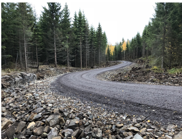
En vei bygget med teknikken "sprengfjellteknikk". Foto: Martin Bråthen, Skogkurs
