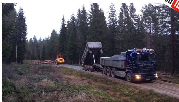
Video 1 - Informasjonsfilm om veivedlikehold med blant annet utlegging av slitelagsgrus fra 2:38.
