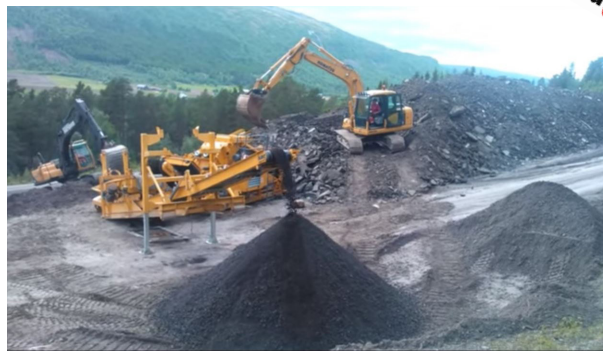
Video 6 - I videoen knuses det asfalt
