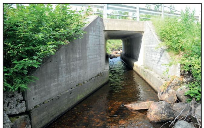
Bilde 3: Når veier krysser noe større bekker og vassdrag, bør det bygges bro eller eventuelt hvelvkulvert der naturlig bekkebunn bevares. Det sikrer gode vandringsveier for fisk.
