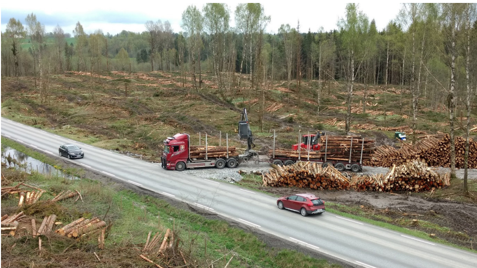
Her er det lagd en vendehammer for tømmerbilen slik at den kan rygge seg inn på velteplassen for å slippe å stå i veien. Dermed reduseres fare for ulykker. Foto: Johannes Enersen, Romeriks Allmenningene.
