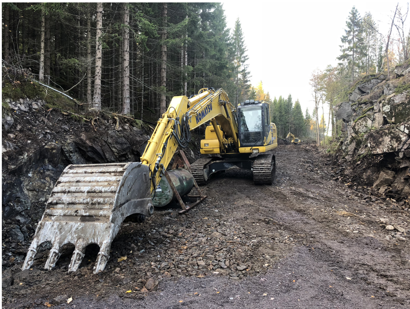
Veier under ombygging. Veien bygges med "sprengfjellteknikk" for å sikre gode masser, lite massetransport og gode vannveier. Foto: Martin Bråthen
