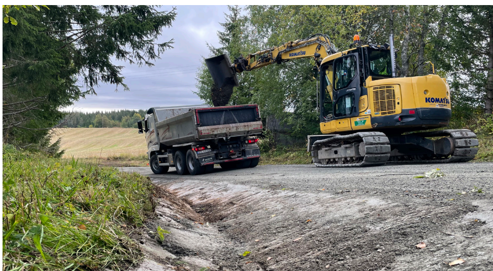
Veilaget skal iverksette vedlikeholdstiltak som for eksempel grøfterensk. Foto: Martin Bråthen.
