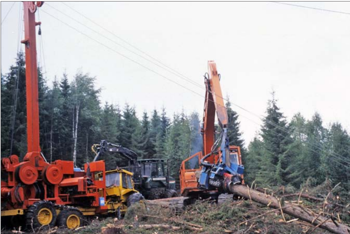
Taubaneentreprenøren må ta til takke med dårlig standplass p.g.a. manglende planlegging og forberedende arbeider. Owren 400 kabelkran kjørt som fallbane. TEJ
