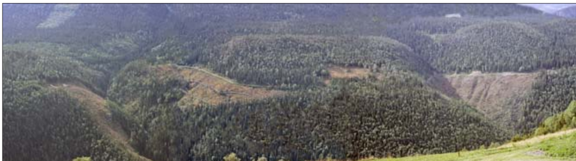
Vegen riktig plassert i lisisiden med gode taubanedrifter og terrasseveger. På oversiden av vegen utløses store areal med traktorierreng. TEJ
