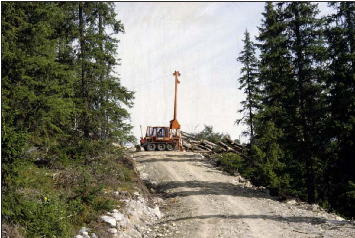
Vinsjing av heltrær til veg. Hogstmaskinen som kommer etterpå avvirker et belte på oversiden av vegen for å kunne legge fra seg tømmeret. Owren Variovinsj. TEJ
